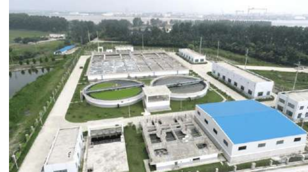
10万吨/天的污水处理工程 10万トン/日の下水処理工事
