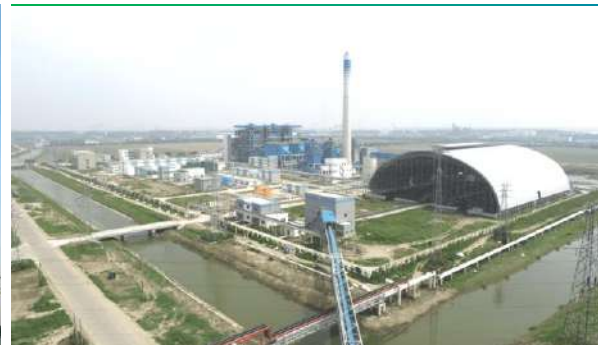
590吨/小时的蒸汽供应 590トン/時間の蒸気供給
