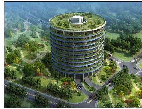
充電タワー Charging Tower
