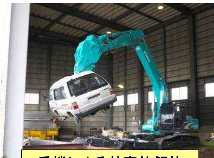
重機による効率的解体
