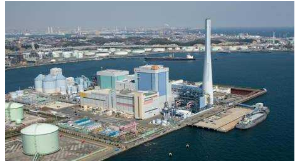
磯子火力発電所 1号機 2002年 磯子火力発電所 2号機 2009年
