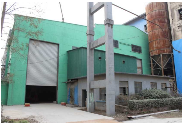
深度脱水污泥储仓
