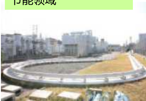
超导电缆系统实际联合运行
