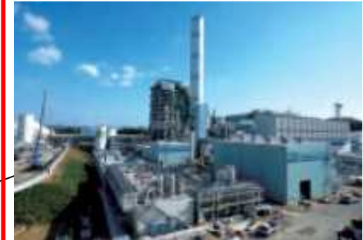
吹氧煤气化复合发电实证设备 (大崎CoolGen项目)
