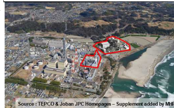
勿来 540MW IGCC 建設中
