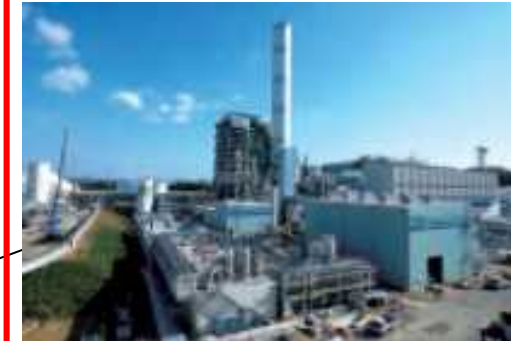
酸素吹石炭ガス化複合発電の実証設備 (大崎クールジェンプロジェクト)
