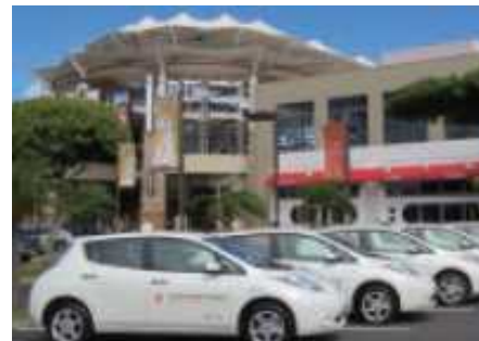
電気自動車(EV)を活用する スマートグリッド技術実証(米国ハワイ州マウイ)
