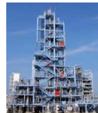
分離回収設備例
