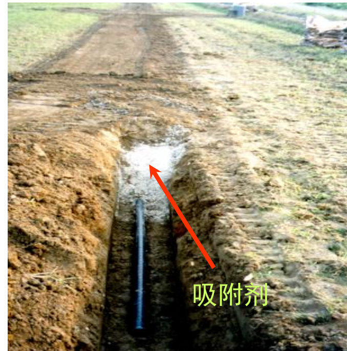
反铲机的暗渠施工
