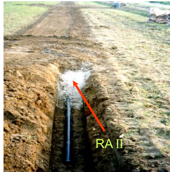
バックホウによる暗渠施工
