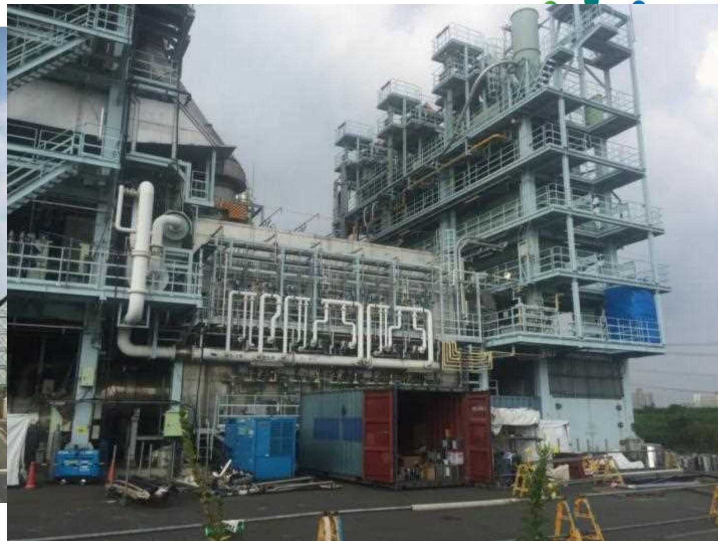
东京都污泥碳化中心 300\text{ton/d} \times 2 套，2007年投入使用4号机组 ( 300\text{ton/d} ) ,2013年投入使用5号机组 ( 300\text{ton/d} )
