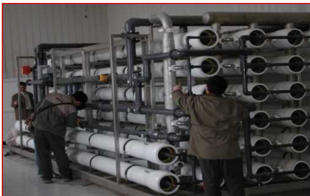
大連長海県RO海水淡水化工事
