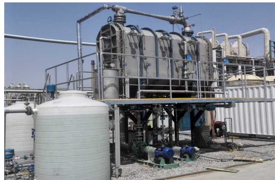
板式MED中間試験装置
