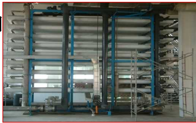
黄島発電所RO海水淡水化工事
