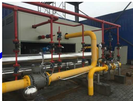
单机双级螺杆膨胀机 单机双级ねじボルト膨胀机
