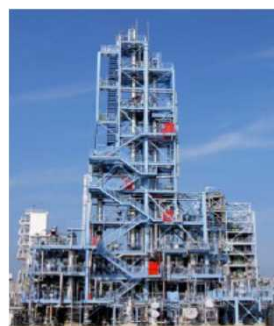
分離回収設備例
