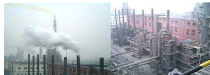
（左：従来の排煙、右：現在の排煙）
