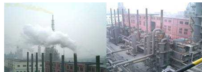
(左:従来の排煙、右:現在の排煙)
