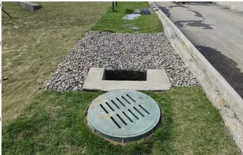
施工现场图 工事の現場
