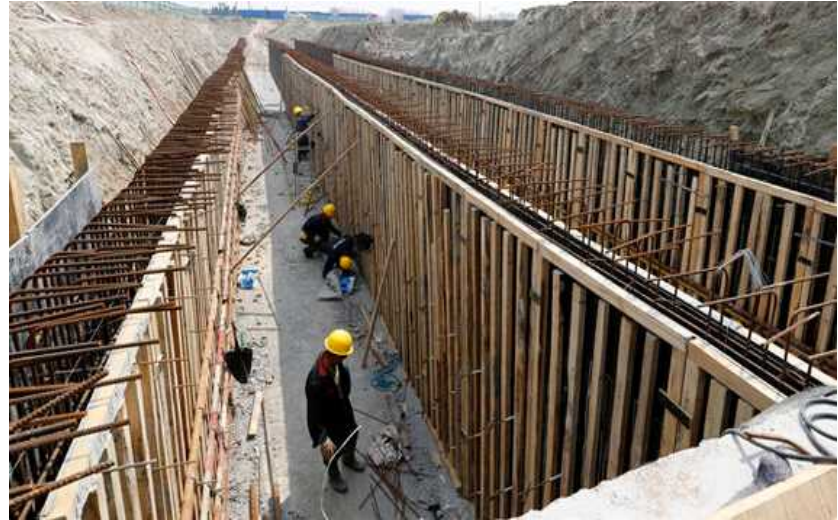
现场施工图 施工现场の写真
