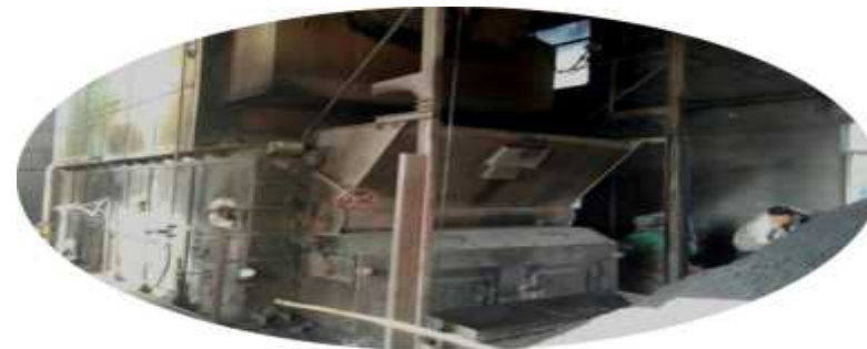
改造前直燃煤链条锅炉 直燃石炭チェーンボイラーを改造した前
