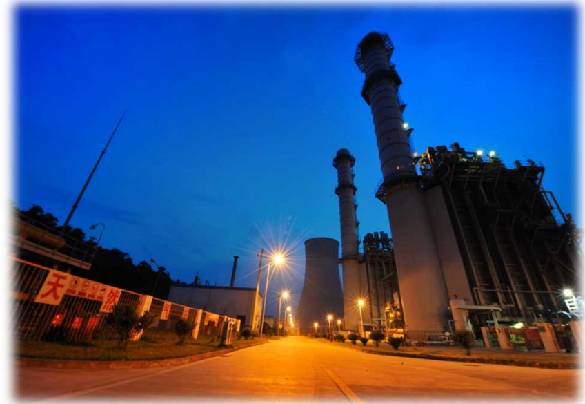
国華余姚熱機関発電所
