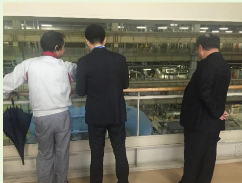
JPOWER磯子発電所
