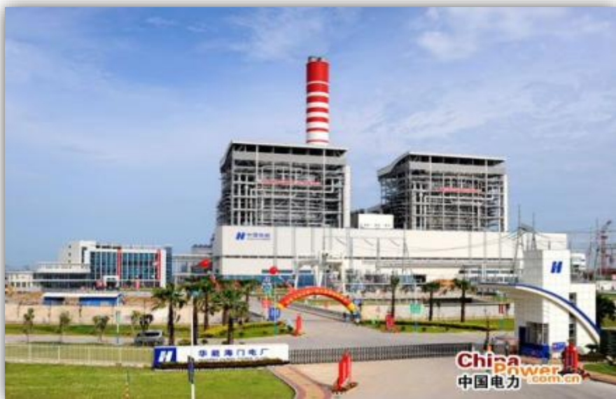
国内最大单机容量的超超临界机组
