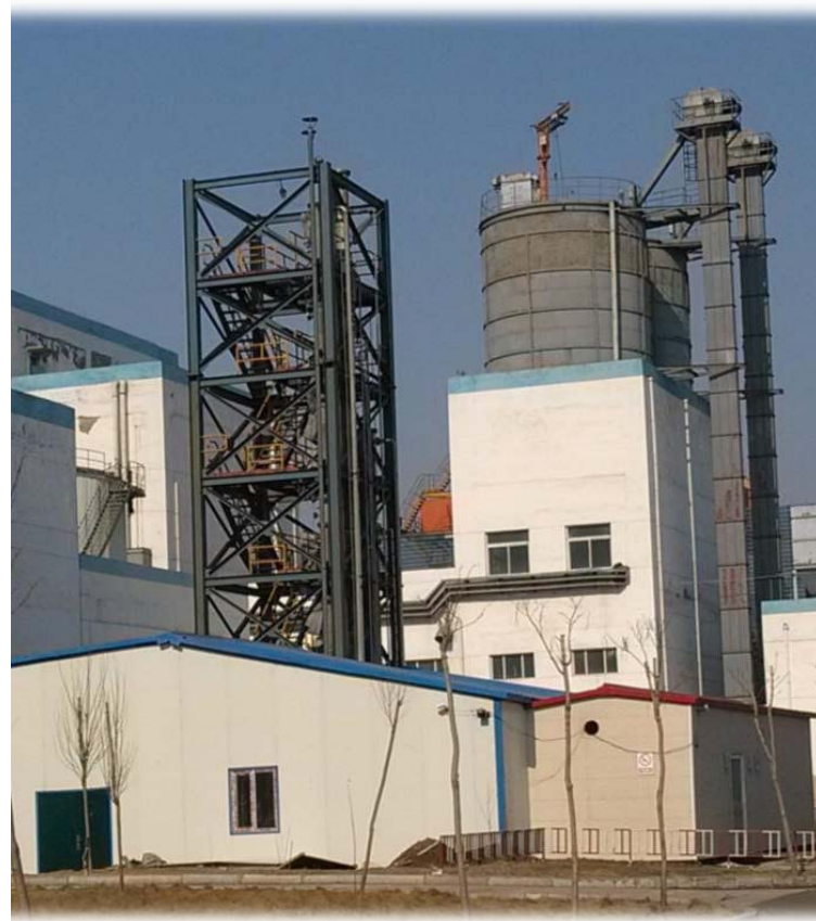
1000吨/年可移动燃煤烟气CO 2 捕集装置，配套超临界CO 2 压缩设备；可用于对新溶剂的性能评估和新工艺开发
