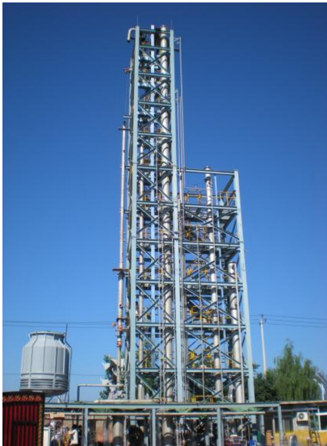
1000吨CO 2 /年天然气电厂二氧化碳捕集试验系统
