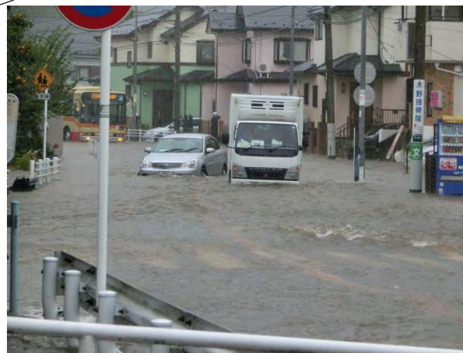
2014年10月 18号台风造成路面浸水 (泉区冈津町)
