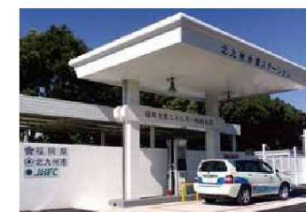
北九州水素 ステーション
