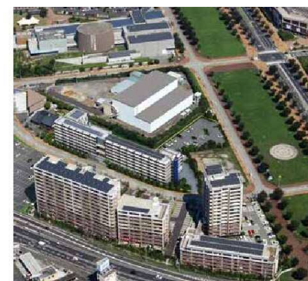
地区内屋根の太陽光発電群
