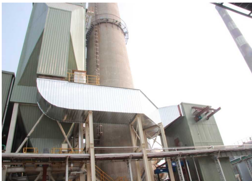
中国第一条达到国际先进水平的调质系统+高温电除尘+SCR烟气治理工程
