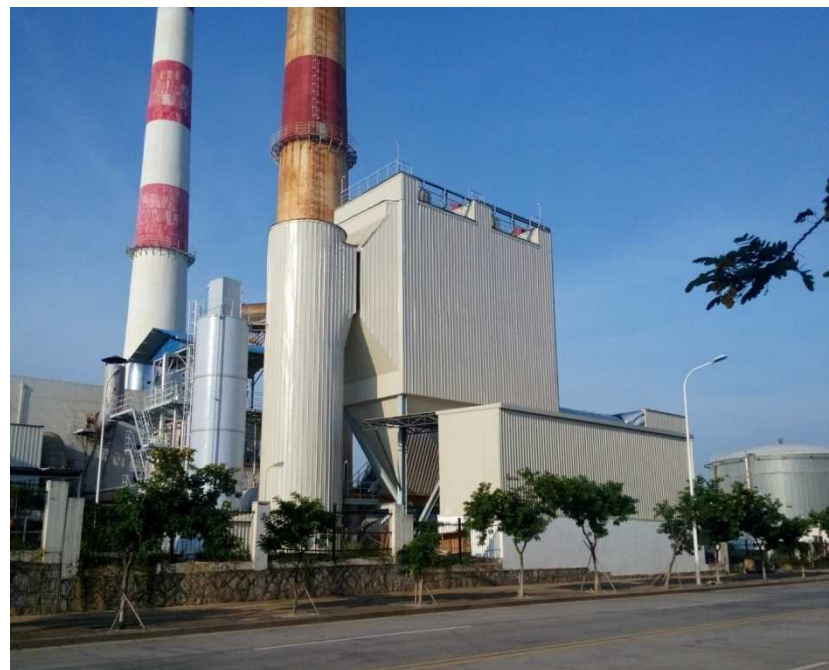
厦门明达除尘脱硝装置，中国第一条成熟并运用于玻璃烟气净化的前置高温干法脱硫技术
