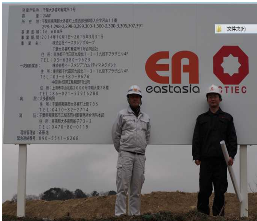
日本千叶 2.054MW 地面光伏电站项目开工
