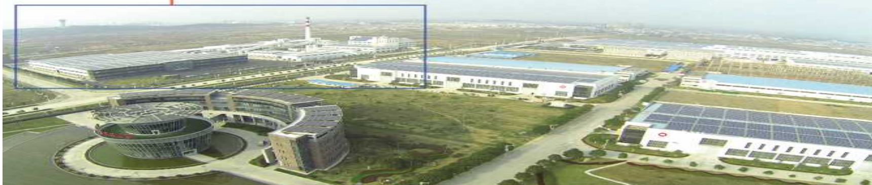
安徽蚌埠 10.08MW 屋顶光伏电站 10.08MW Rooftop project in Bengbu, Anhui
