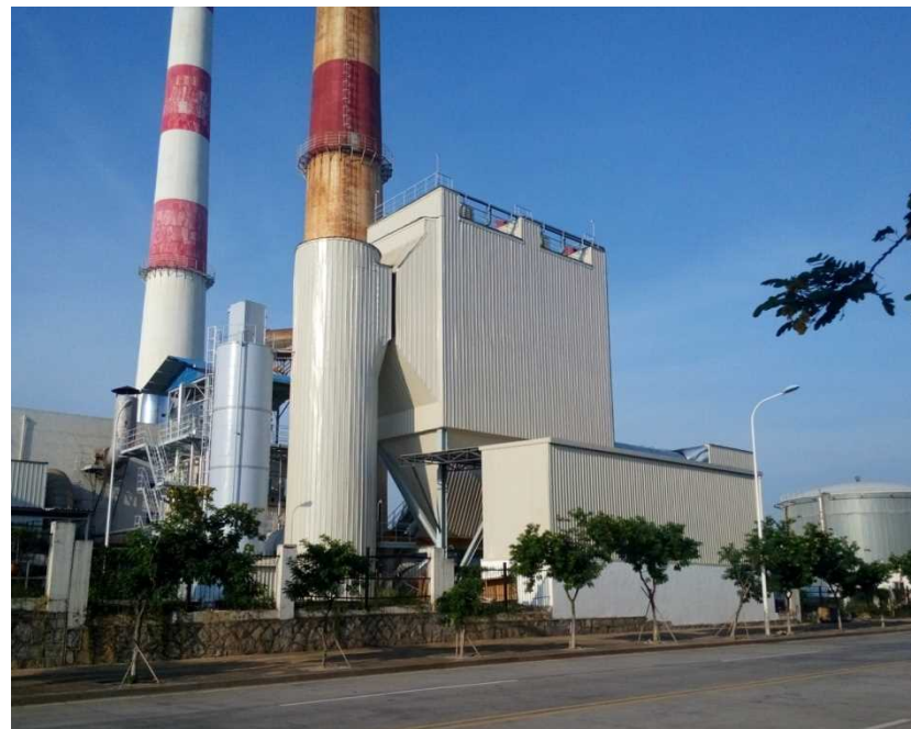
厦門明達脱塵脱硝装置 中国初のガラス工場排気処理の前置き高温乾式脱硫 案件
