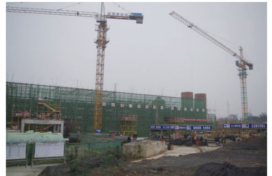
成都市で建設中の汚泥焼却処理プラントを視察。
