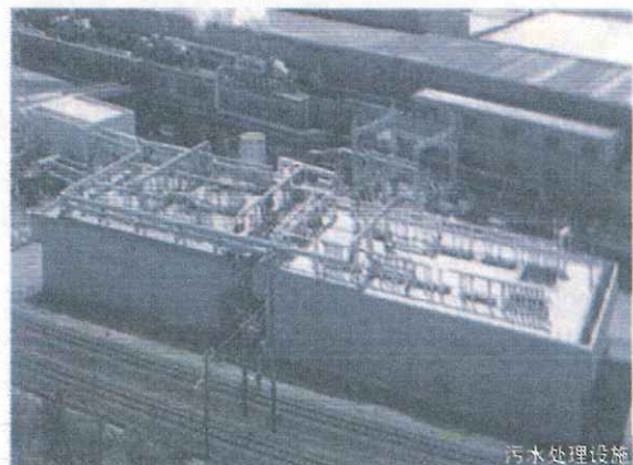
污水处理设施
