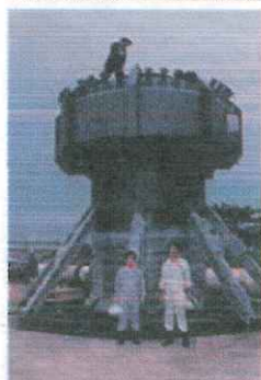
浓缩海水放流塔
