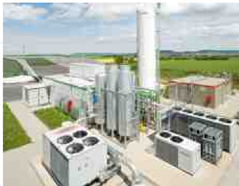
德国1000m 3 /h垃圾及粪污沼气提纯项目 ドイツ1000m 3 /hゴミと糞メタンガス精製プロジェクト
