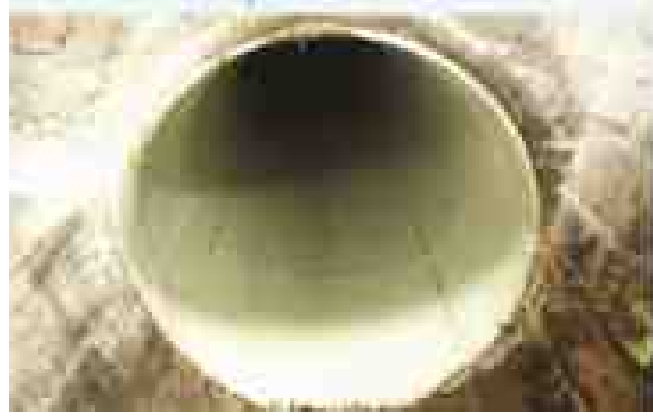
管道非开挖修复—紫外线光固化
