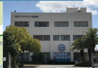
ポートアイランド 処理場
