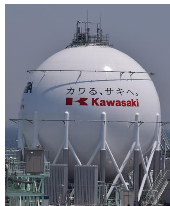
国内最大 液化水素タンク (神戸液化水素荷役ターミナル)
