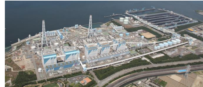
実機におけるアンモニア混焼実験の有力候補地点である碧南火力発電所
