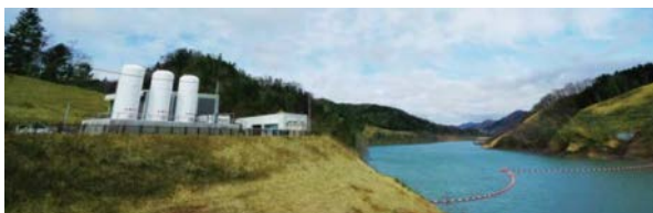
北海道氢能供应链实证项目 环境省 委托项目
