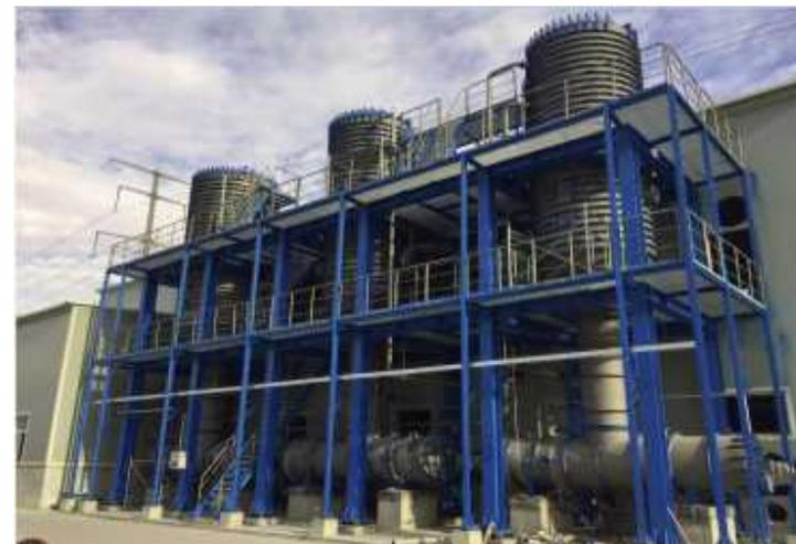
新疆东方希望电厂1000吨/日脱硫废水机械压缩蒸馏零排放工程
