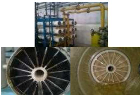
开发反渗透膜离线清洗技术，效果显著
