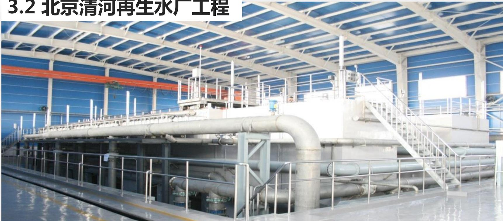
针对再生水中的**浊度**和**色度**指标，采用**超滤膜和臭氧集成的污水深度处理工艺**。
