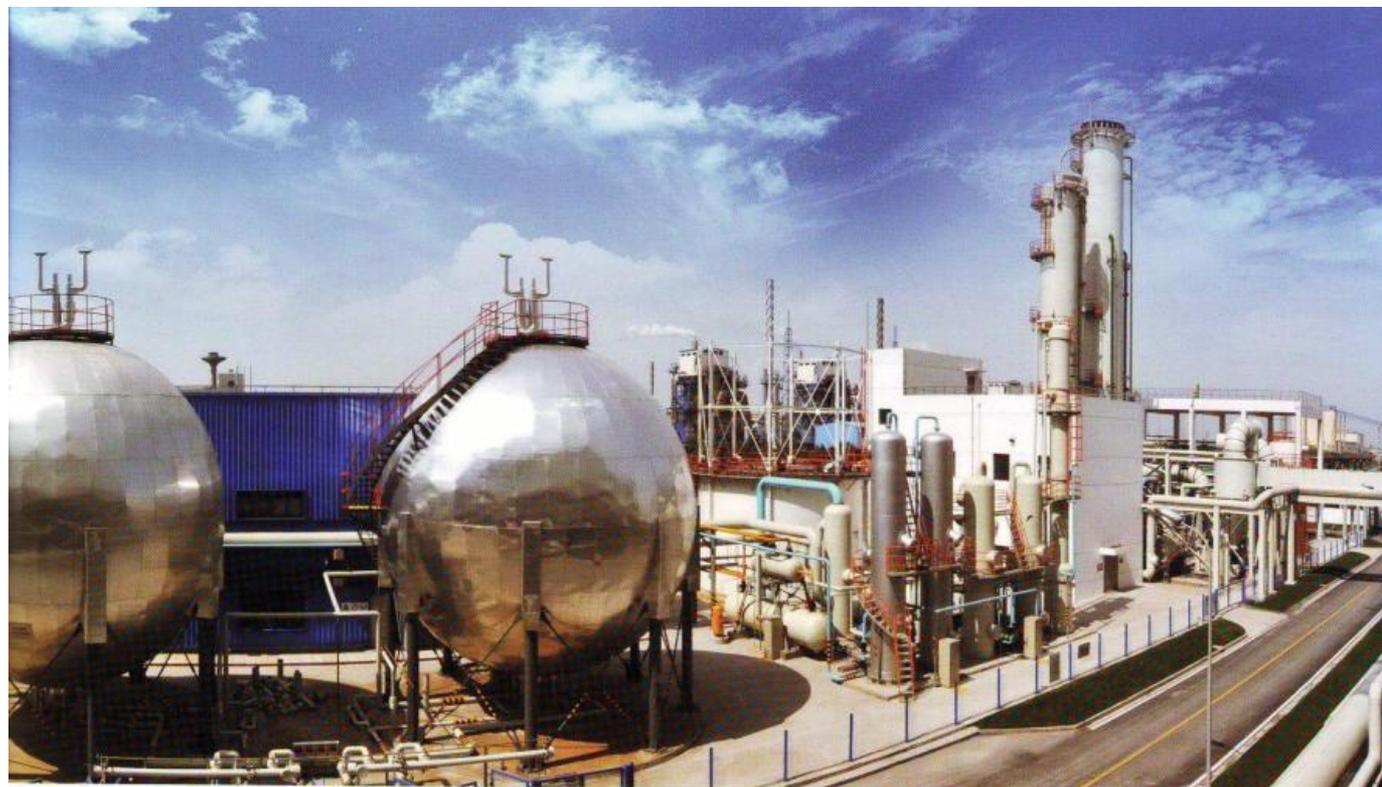
2009年、華能は上海石洞口第2発電所に**当時世界最大**の、CO<sub>2</sub>回収貯留能力が**12万トン/年**の石炭火力発電所を建設した。
