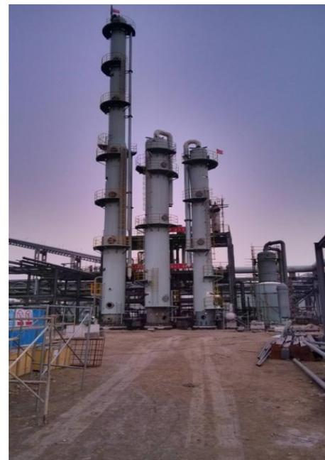
25万KW IGCC発電プラントに基づいて、バイパスを利用することにより、現在熱効率30MWの環境調和的（緑色）石炭火力発電研究室や、6-10万トン/年の燃焼前のCO<sub>2</sub>回収貯留装置を建築し、燃焼前のCO<sub>2</sub>回収貯留技術研究を行っている。
