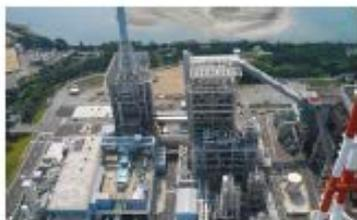
脱硝, 脱硫烟气处理装置
