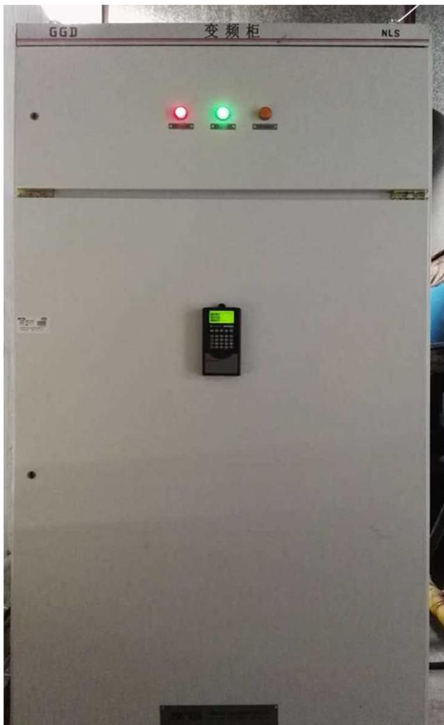
**改良内容:**2台のインガーソールランドのスクリーマーマシンに周波数変換器及びコントロールシステムを設置した。
