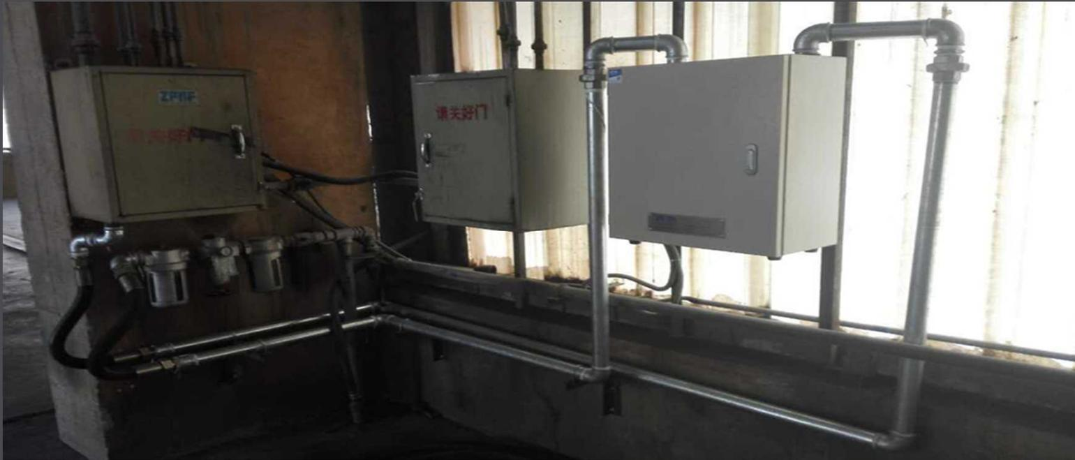
改良内容: 電解槽の入り口でシェルシリンダー知能バルブ(切替バイパスつき)を一台設置する;
