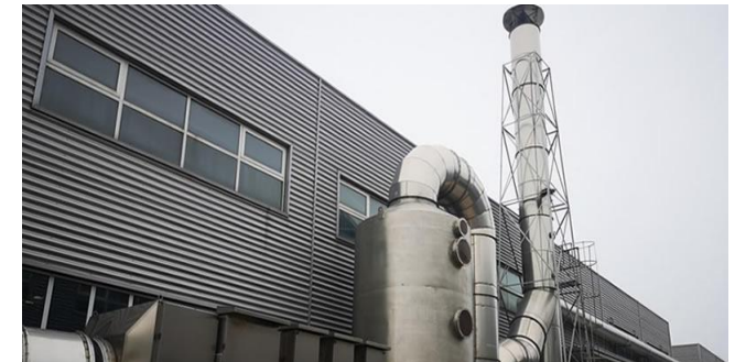
環保設備の取付工事 (低温プラズマ・光触媒酸化などの低効率処理設備更新)
